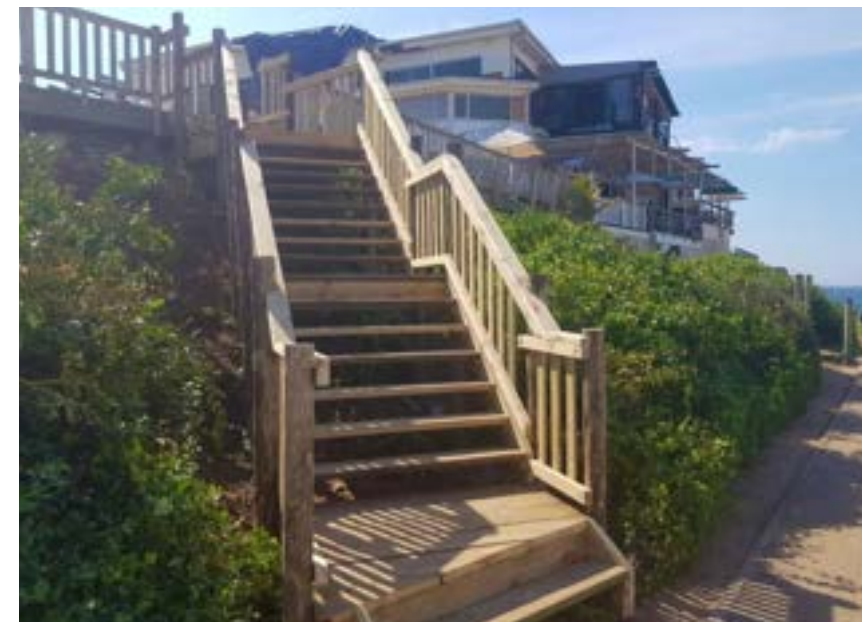
Tedder Way Promenade Stairway Relocation
